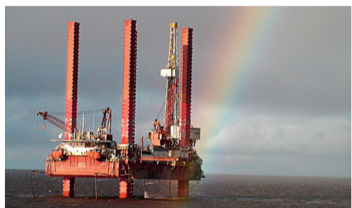
СПБУ «Амазон» находится в эксплуатации ООО «Газпром флот» с 2001 года
