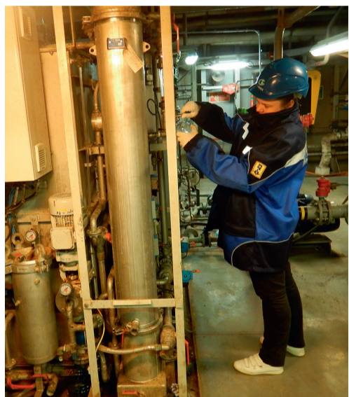
Отбор проб сточных вод в рамках производственного экологического контроля
